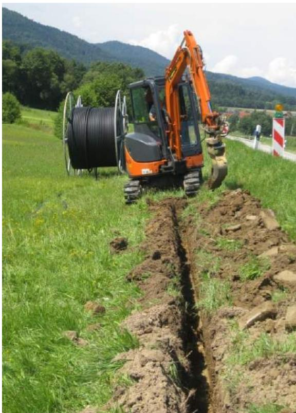
Durch den Einsatz des Tiltrotators können zahlreiche Arbeiten mit dem Bagger schnell und einfach erledigt werden. Handarbeit ist nicht mehr notwendig, auch querende Leitungen, Hausanschlüsse etc. stellen kein Problem dar.
