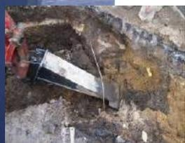
Der Räum- und Ziehspaten wird gefertigt für Einsätze im Kanalbau und für andere Baumaßnahmen. Er kann über entsprechende Adapterplatten an unterschiedlichsten Baggern zum Einsatz kommen. Über die Löffelkinematik wird dann mit dem Spaten im Graben gearbeitet.
