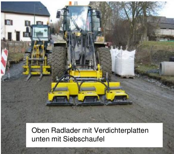
Oben Radlader mit Verdichterplatten
