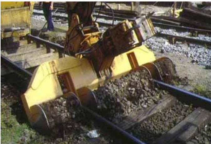
Mit dem Schwellenwechselgerät erreichen Sie Höchstleistungen. Mit dem Bagger kann die zu ersetzende Schwelle schnell und einfach gelockert werden. Der Schotter wird aufgenommen, die Schwelle wird herausgehoben.
